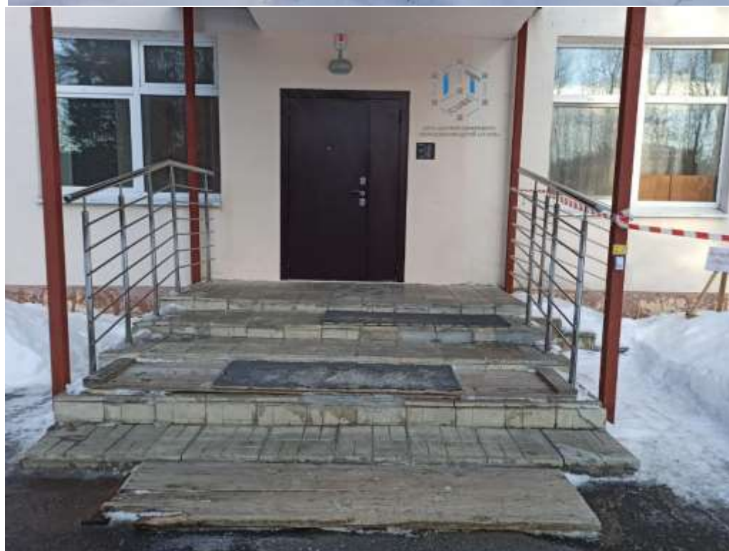
Двухэтажное здание с отдельным входом
